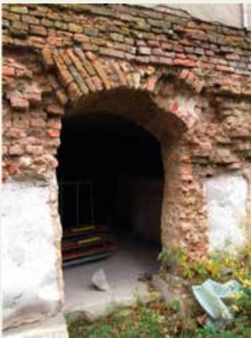
Rundbogen im Kellergewölbe (C. Karus) - rondboog in het keldergewelf
