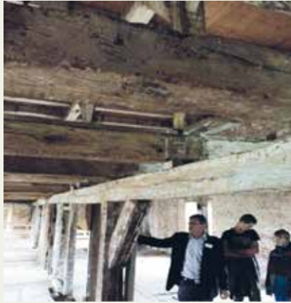
Im Dachgeschoss der Remise (C. Karus) Op de zolder van de remise
